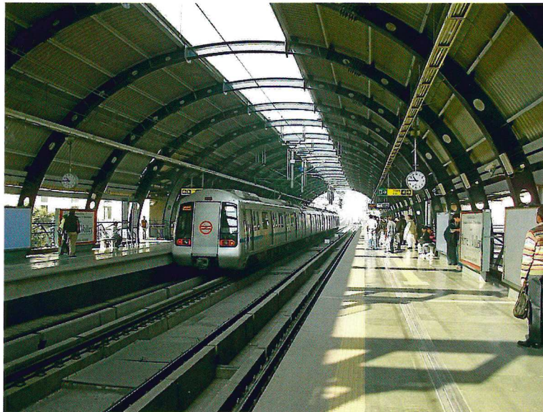
Delhi Metro Station Noida City Centre, ausgerüstet mit MOBATIME Uhren (Bilder: BÜRK MOBATIME GmbH/MOSER BAER AG).
